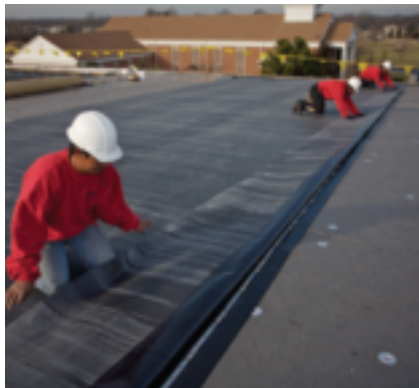
Install membrane.
